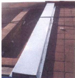
Filtración de agua en la terraza en las uniones de las juntas inexistentes
