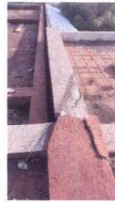
Filtración de agua por la terraza causada por daños a la infraestructura
