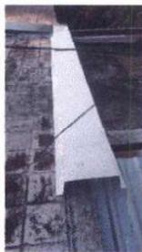
Filtración de agua en la terraza en las uniones de las juntas inexistentes
