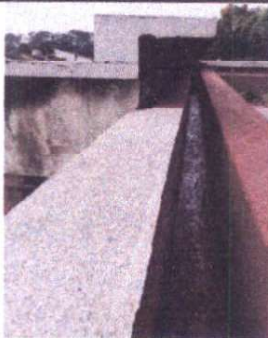
Filtración de agua en la terraza en las uniones de las juntas inexistentes
