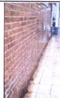
Filtración de agua en las paredes del pasillo de modulo I al módulo II
