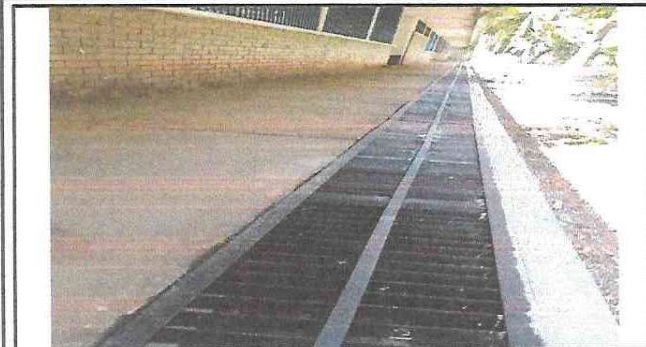
Foto 1: Finalización satisfactoria de elaboración de cuneta de cemento con rejía metálica, área verde del primer módulo.
