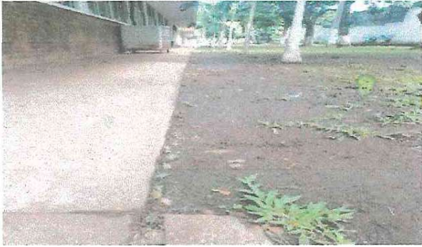
Foto1: ES NECESARIO HACER CUNETETA PARA QUE EL AGUA NO SUBA A LA BANQUETA Y NO ENTRE A LOS CORREDORES DEL INSTITUTO
