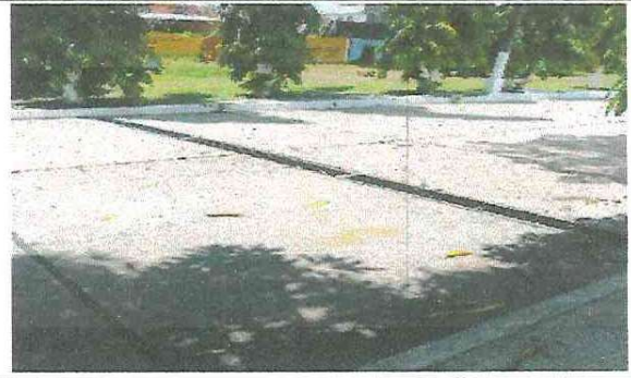
Foto 6: FOTOGRAFÍA DONDE SE REFLEJA EL TAMAÑO DE LA REJILLA LA CUAL ES ES NECESARIO LA AMPLIACION PARA MEJOR FUNCIONAMIENTO.
