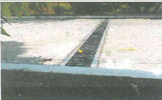
Foto 5: ILUSTRAMOS LA REJILLA DE LA ENTRADA PRINCIPAL LA CUAL SE PRETENDEN AMPLIAR PARA MEJOR CAPTACION DEL AGUA PLUVIAL
