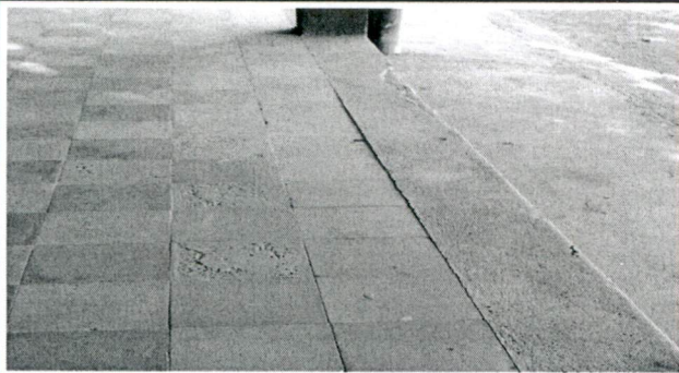
Sustitución de piso de concreto por piso cerámico
