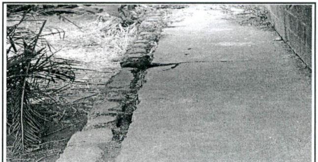
Sustitución de banqueta de concreto
