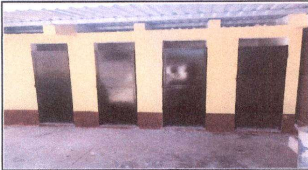
Foto1: Sustitucion de puerta de madera por puerta de metal
