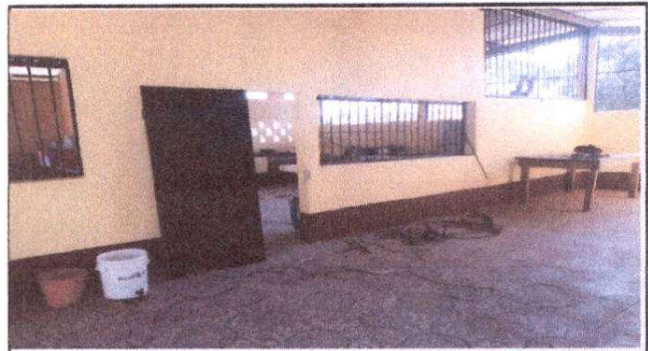
Foto 4 Sustitucion de ventana y puerta de madera por valcón y puerta de metal.
