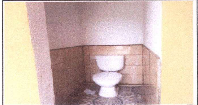
Foto 2: Sustitución de sanitario por sanitarios, colocación de azulejo, cernido, aplicación de pintura, sustitución de piso líquido por piso ceramico
