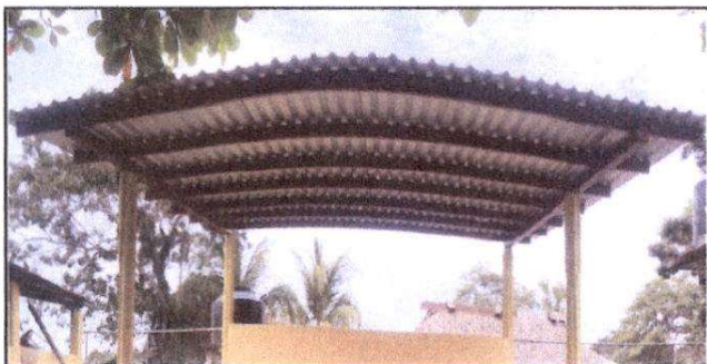
Foto 5: sustitución de lamina por lamina troquelada y soporte de madera por soporte de metal
