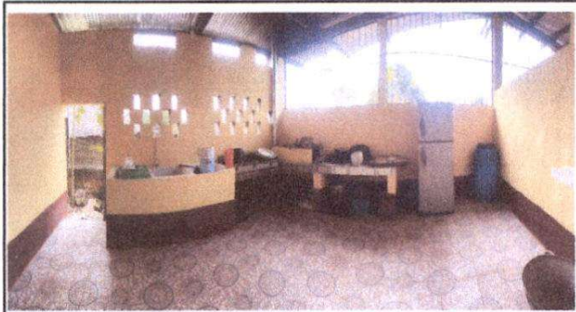
Foto 3: Sustitucion de polleton por estufa rural, sustitución de pila de 2 lavaderos fundidas, sustitucion de piso liquido por piso ceramico y aplicación de pintura
