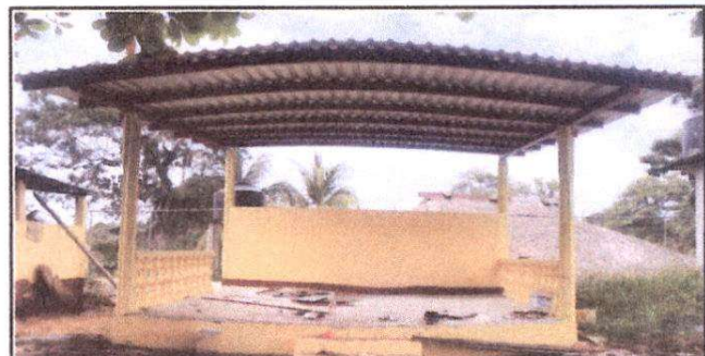
Foto 6: sustitucion de piso liquido por piso ceramico, aplicación de pintura
