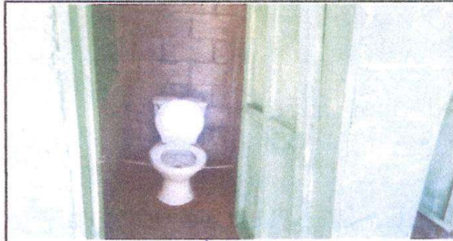
Foto 2: Sustitución de Sanitario por Sanitarios
