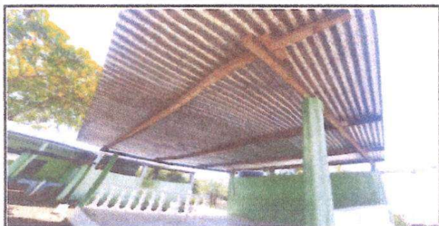
Foto 5: Sustitución de lamina por lamina troquelada
