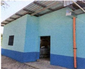
Foto1: Paroques internas y externas pintadas con pintura de aceite anticorrosiva.
