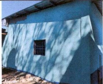
Foto 3: Repello y cernido de la cocina en el interior y exterior
