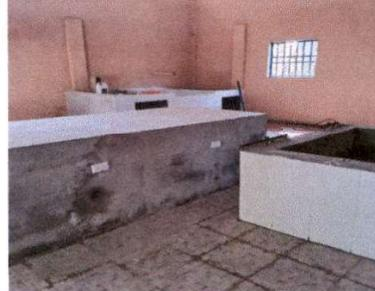
Foto 2: Derribación de pared en la cocina, para agrandarla y puesta de piso ceramico en todo su entorno.
