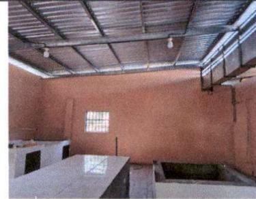
Foto 4: Lámina troquelada y costaneras galvanizadas para el techo de la cocina
