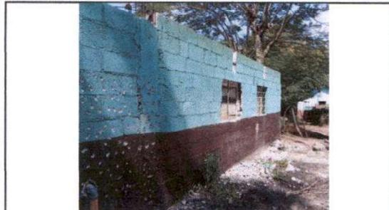
Foto 3: Remozamiento de repe y cernido de la paredes externas
