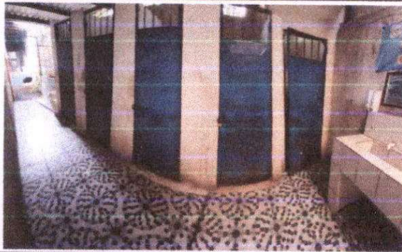
Mantenimiento a estructura (lijado, cambio de tubo , cepillado, sujeciones, aplicación de pintura)
