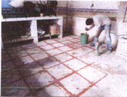
Instalacion de piso ceramico antideslizante
