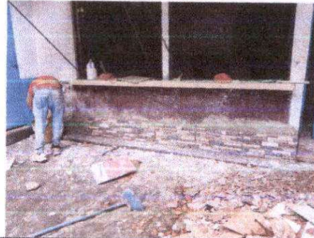
Instalacion de fachaleta
