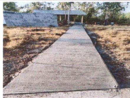
Foto 4: Cambio de camino de adoquin por concreto de la cocina hacia los salones.
