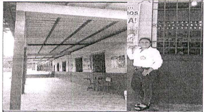
Sustitución de balcones de madera y de metal picados en aulas.
