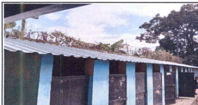
Foto 5: Sustrucción cubierta de lámina en servicios sanitarios
