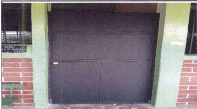
Foto 1: Sustrucción de puertas de madera por metal
