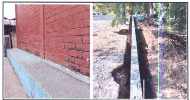
Foto 6: Reparación de fisura en gradas de área recreativa y reparación de socavamiento en losa de concreto de cancha polideportiva
