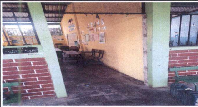
Foto1: Sustitución de puertas de madera por metal
