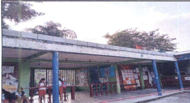
Foto 3: Impermeabilización de losa y reparación de pañuelos de concreto
