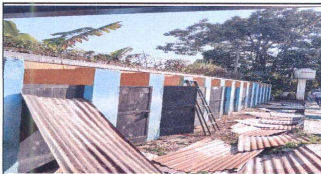
Foto 5: Sustitución cubierta de lámina en servicios sanitarios
