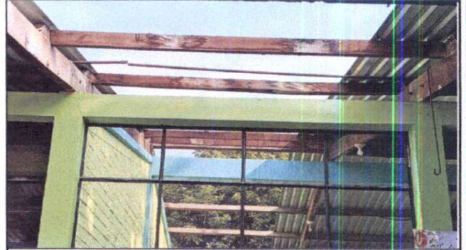
Foto 2: Sustitución de lámina duralita por lámina troquelada calibre 26
