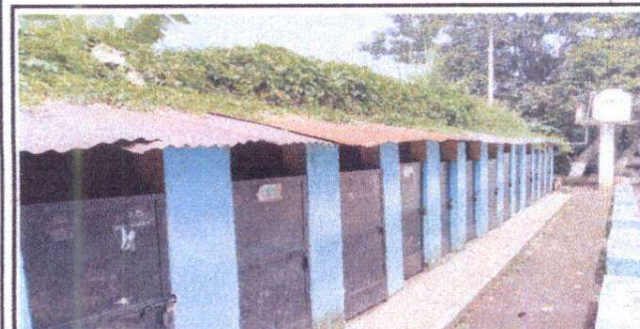
Foto 5: Sustitución cubierta de lámina en servicios sanitarios
