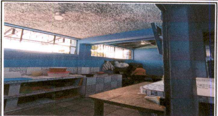
Foto 2: Aplicación de pintura en muros de cocina
