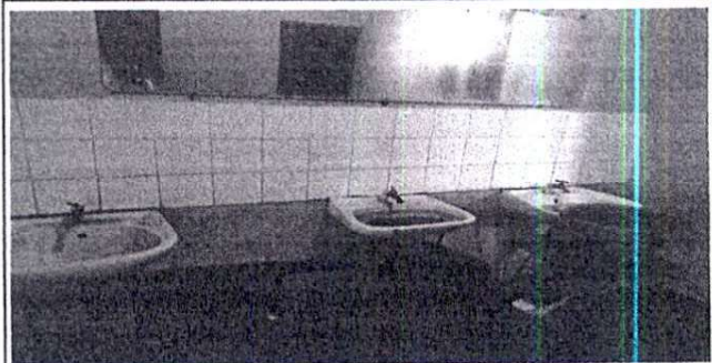
Reparación de servicios sanitarios
