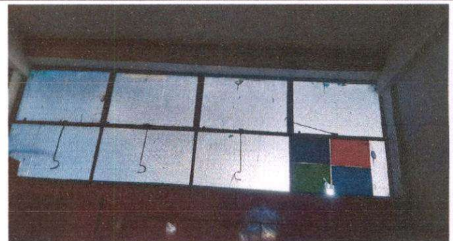
Foto 12: Servicio sanitario. Mantenimiento de ventana de metal.
