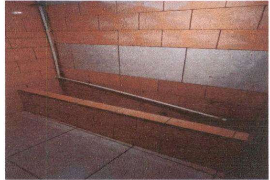
Foto 8: Servicio sanitario. Instalación de tubería para migitorio.
