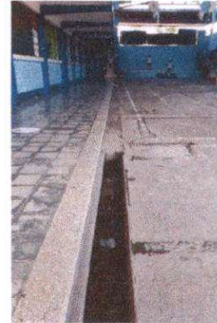
Foto 14: Red de drenaje. Colocación de 6 cajas con rejas.
