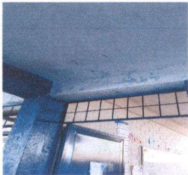
Foto 23: Módulo III. Filtración de agua en corredor.
