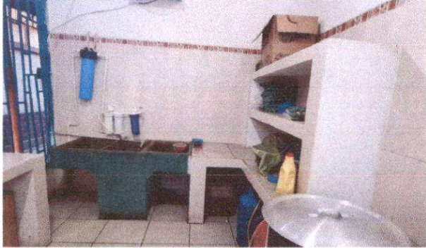
Foto 1: Cocina. Sustrucción de pila de concreto.
