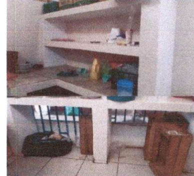
Foto 2: Cocina. Instalación puerta de metal de gabinete.
