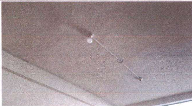
Foto 11: Servicio sanitario. Reparación sistema eléctrico.
