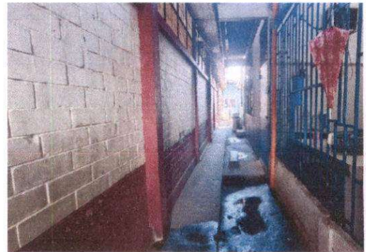
Foto 16: Red de drenaje. Sustitución tubería línea principal con 4 cajas con rejas.
