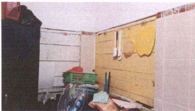
Foto 3: Cocina. Sustrucción de ventanas de madera por metal.
