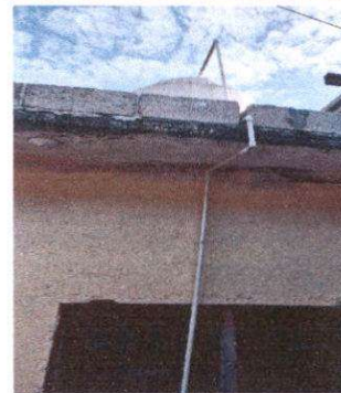
Foto 4: Reparación y mantenimiento de sistema/depósito de agua. Sustrucción de depósito de agua 1700 lt.
