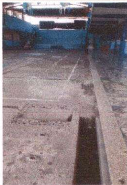
Foto 15: Red de drenaje. Colocación de 6 cajas con rejas.
