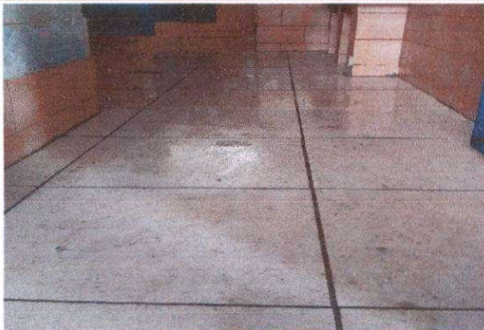
Foto 9: Servicio sanitario. Sustitución de drenaje con cajas sifón.
