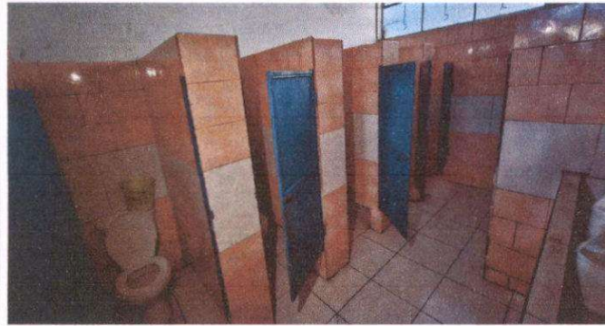
Foto 7: Servicio sanitario. Mantenimiento a puertas de metal.
