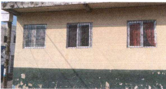
Foto 11: Suministro de ventanas de PVC en aulas
