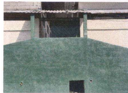
Foto 12: Mantenimiento de portón 3 de estructura metálica
