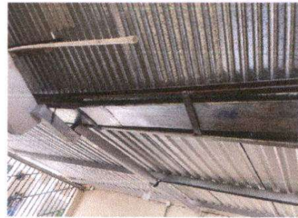
Foto 8: Sustitución de canal de metal y PVC por canal de metal
