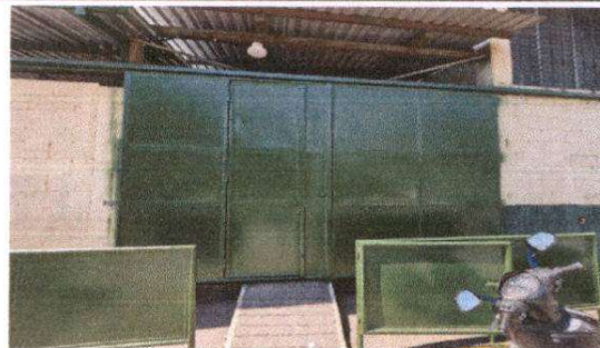
Foto 10: Mantenimiento de portones de estructura metálica
