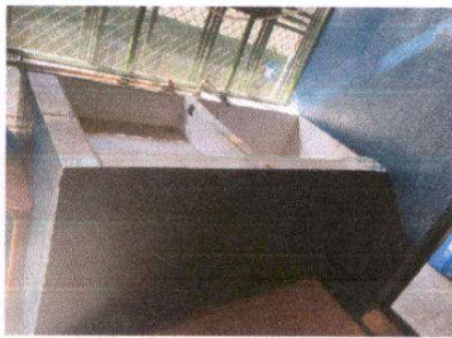
Foto 9: Reparación de pila de concreto
