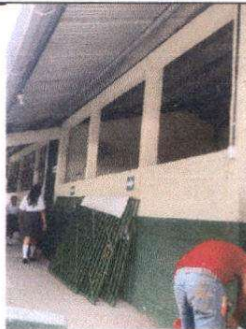
Foto 5: Suministro e instalación de balcones, sustitución de canales y bajadas de agua pluvial
