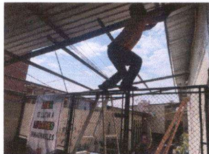
Foto 6: Sustitución de cubierta de lámina y estructura de soporte en servicios sanitarios
