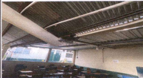
Foto 8: Sustitución de canal de metal y PVC por canal de metal
