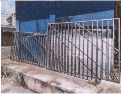
Foto 7: Suministro e instalación de balcones de metal y suministro e instalación de puertas de estructura metálica en aulas
