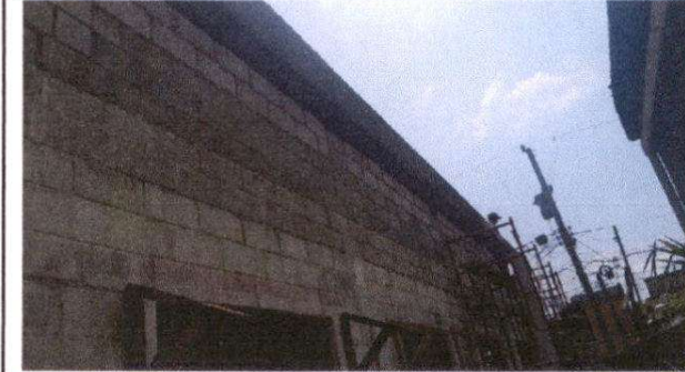
Foto 4: Mejoramiento de altura de pared pineada y fundición de solera de amarre para soporte de estructura de techo
