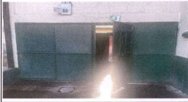
Foto 2: Mantenimiento de portones de estructura metálica.
