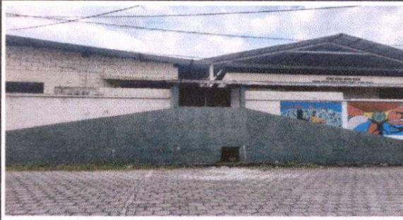
Foto 12: Mantenimiento de portón 3 de estructura metálica
