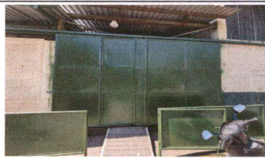
Foto 10: Mantenimiento de portones de estructura metálica
