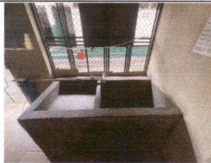
Foto 9: Reparación de pila de concreto
