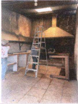
Foto 1: Reparación en área de cocina
