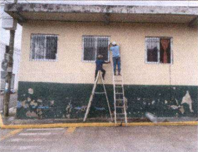
Foto 11: Suministro de ventanas de PVC en aulas
