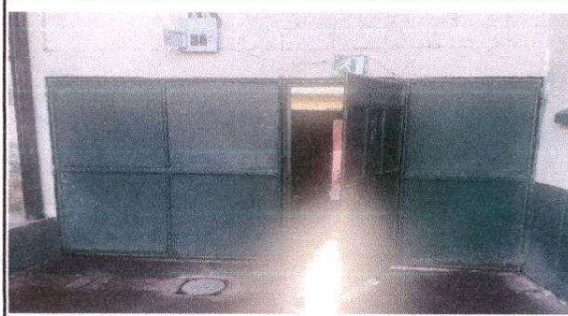
Foto 2: Mantenimiento de portones de estructura metálica.
