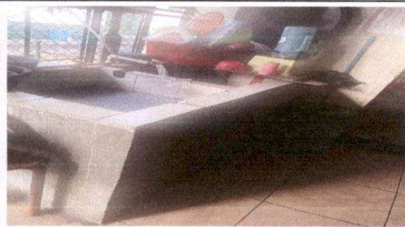
Foto 9: Reparación de pila de concreto
