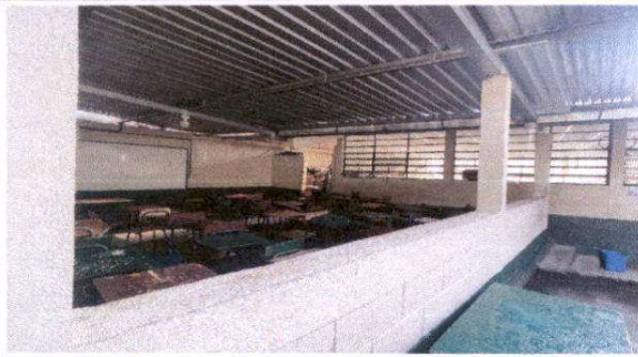
Foto 7: Suministro e instalación de balcones de metal y suministro e instalación de puertas de estructura metálica en aulas
