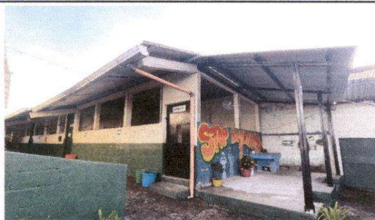
Foto 5: Suministro e instalación de balcones, sustitución de canales y bajadas de agua pluvial
