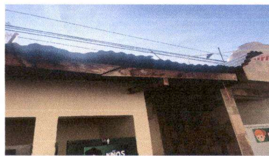
Foto 6: Sustitución de cubierta de lámina y estructura de soporte en servicios sanitarios
