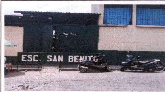
Foto 10: Mantenimiento de portones de estructura metálica
