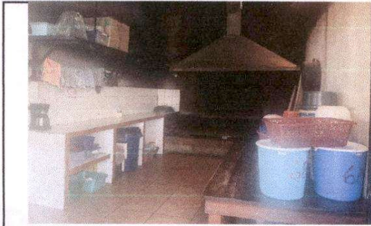
Foto 1: Reparación en área de cocina
