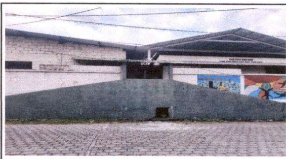
Foto 12: Mantenimiento de portón 3 de estructura metálica
