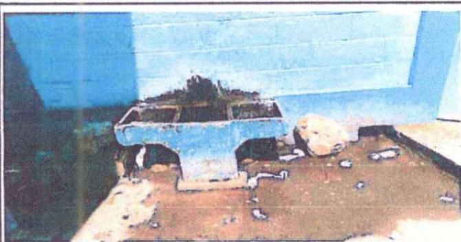
Foto 5: Sustitución de pila de concreto de dos lavaderos por lavamanos de concreto fundido revestido de azulejo con 4 chorros y sustitución de losa de patio por adoquín decorativo
