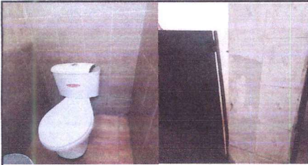
Foto 1: Sanitarios, ouertas y azulejos
