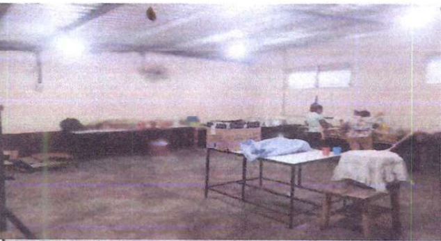
Foto 5: Sustitución de piso de cocina
