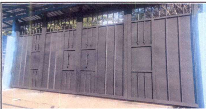
Foto 5: Colocación de portón 06/12/2024.
