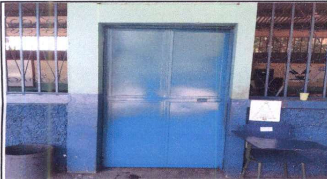
Foto 3: Sustitución de puertas de las aulas 06/12/2024
