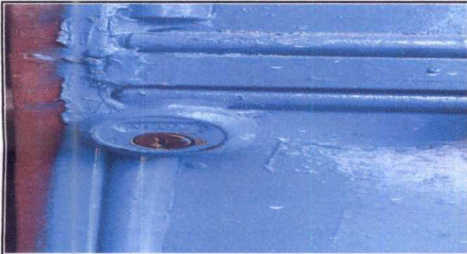
Foto 3: Cambio e instalación de puertas de metal 11/11/2024
