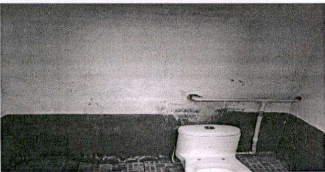
Suministro de azulejo en servicios sanitarios
