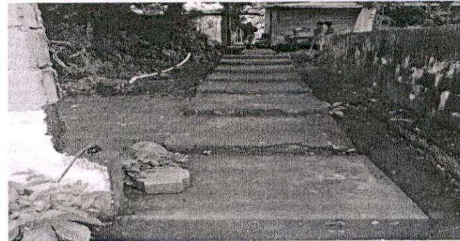
Sustitución de banqueta de concreto.
