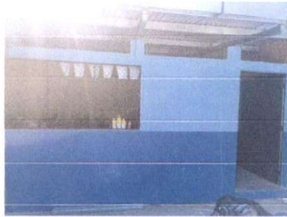
Foto13: Finalización de pintura y canales del aula de primer grado.
