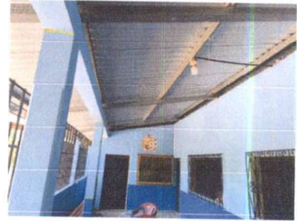
Foto 8: Finalización de pintura muro de exteriores del corredor.
