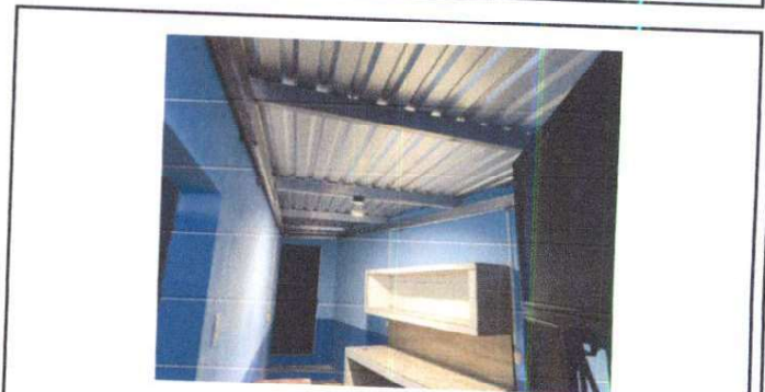
Foto 4: Finalización del gabinete de concreto, pintura, sustitución de techo y estructura metálica.
