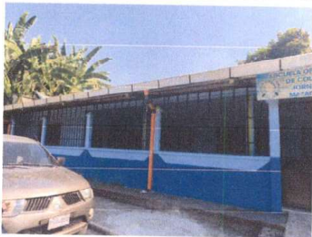
Foto 9: Finalización de pintura de fachada, instalación de canales del centro educativo.
