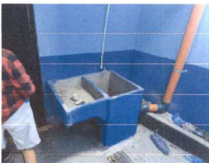
Foto 17: Finalización de sustitución de pila.
