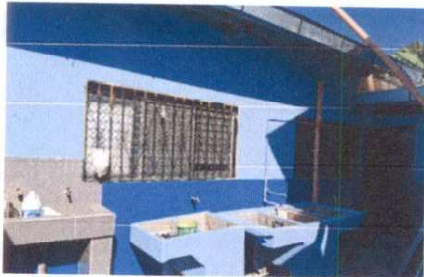
Foto 7: Finalización de pintura de pilas y instalación de canales.
