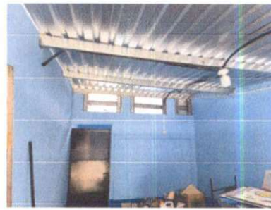
Foto 16: Finalización de sustitución del sistema eléctrico.
