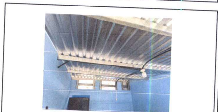
Foto 6: Finalización de pintura, sustitución de techo y estructura metálica en aula cuarto primaria.
