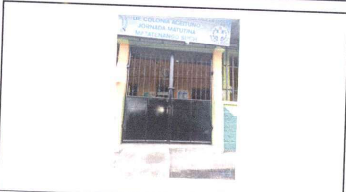
Foto 1: Sustitución de portón de estructura metálica.
