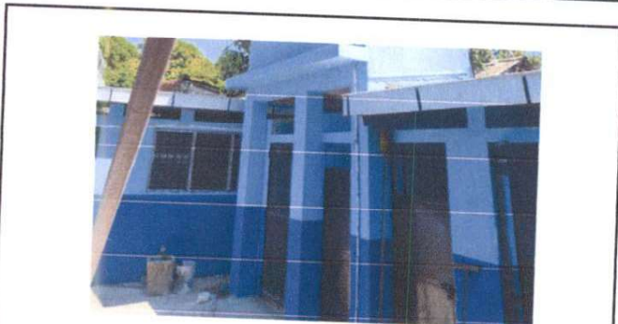
Foto 5: Finalización de pintura, remozamiento de puertas de los sanitarios y instalación de canales.
