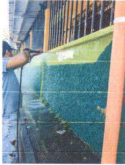
Foto 9: Proceso de limpieza para aplicar la pintura.
