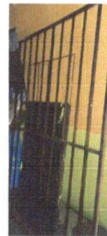
Foto 12: Proceso de sustitución de puerta de pasio.
