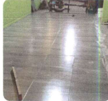
Foto 2: Sustitución de piso de granito por piso cerámico.
