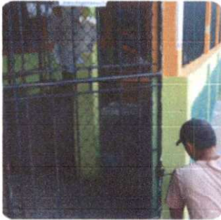
Foto1: Sustitución de porton de porton de estructura metálica.
