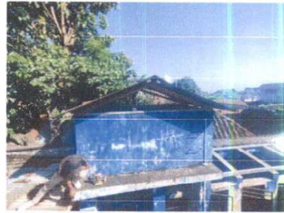
Foto 10: Proceso de instalación de techo y estructura de sanitarios.
