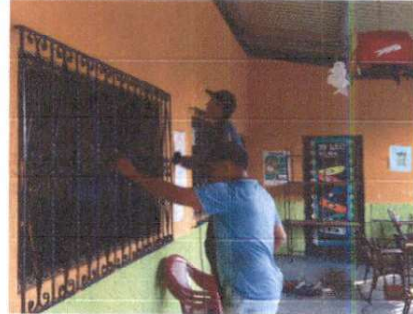
Foto 8: Proceso de reparación de balcones.
