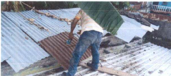
Foto 11: Proceso de reparación de filtraciones.
