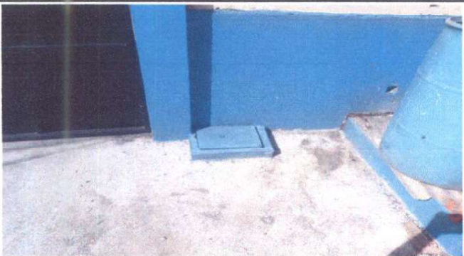
Foto 3: Sustrucción de cajas de registro de tubería para abastecimiento de agua.
