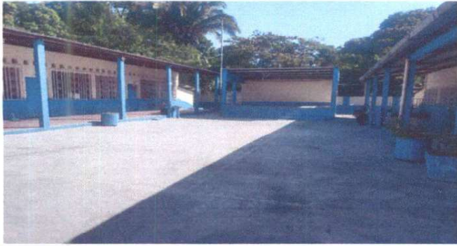
Foto1: Sustrucción de losa de patio de concreto de 12 cm. de espesor
