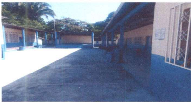
Foto 5: aplicación de pintura en muros interiores y exteriores.
