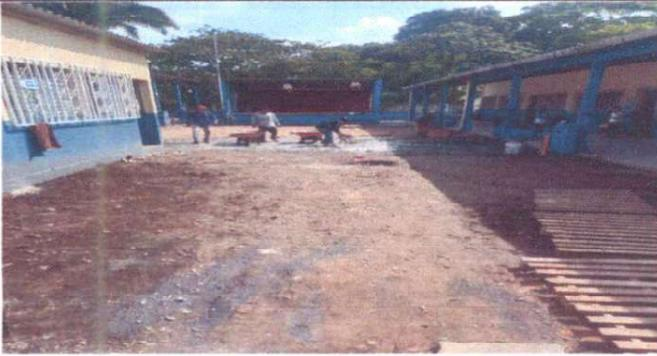
Foto1: Sustitución de losa de patio de concreto de 12 cm. de espesor
