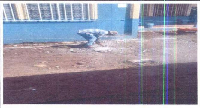
Foto 4: Sustitución de tubería de abastecimiento de agua.
