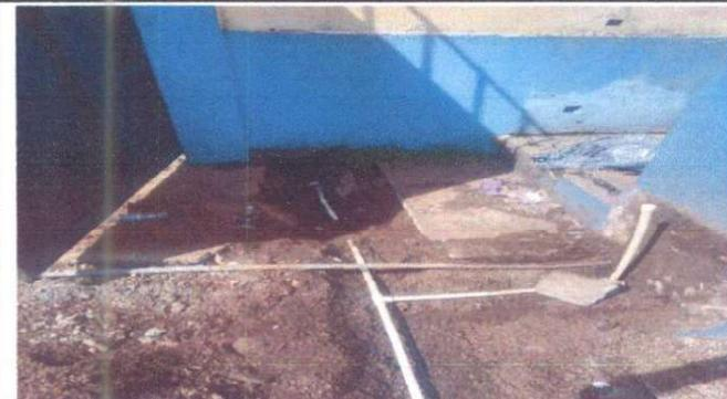
Foto 3: Sustitución de cajas de registro de tubería para abastecimiento de agua.
