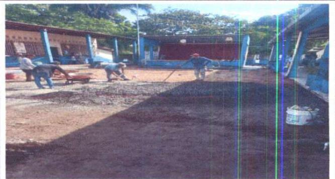
Foto 2: Sustitución de losa de patio de concreto de 12 cm. de espesor, sustitución de tubería de abastecimientos de agua.
