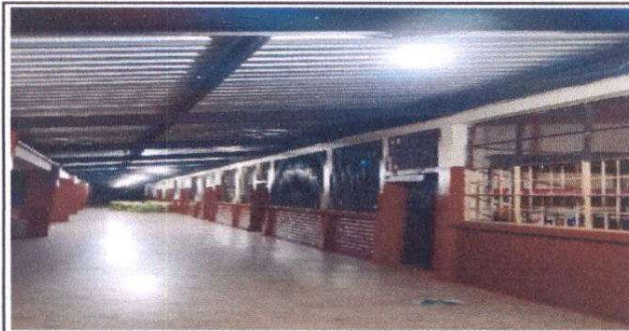
Reparación sistema eléctrico (cambio de lámparas, cableado, interruptores dobles) SALONES DE CLASES, MODULO 1
