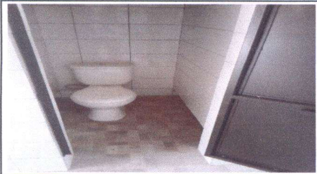
Sustitución de inodoro y sus accesorios.
