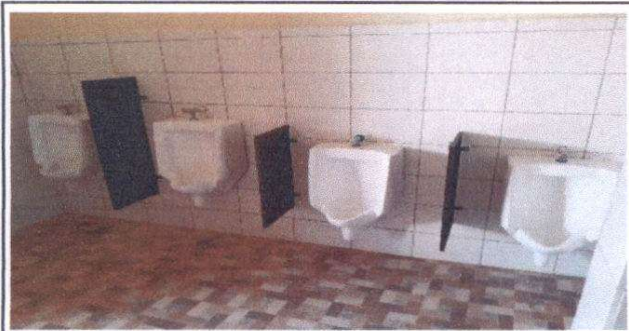
Instalación de mingitorios con sus accesorios.
