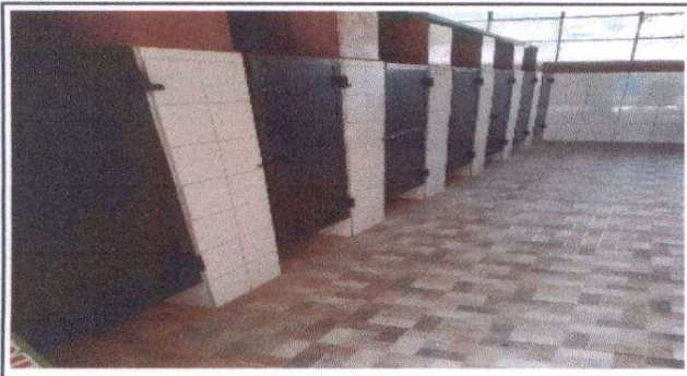
Sustitución de puertas de 0.90 x 1.40 mt.
