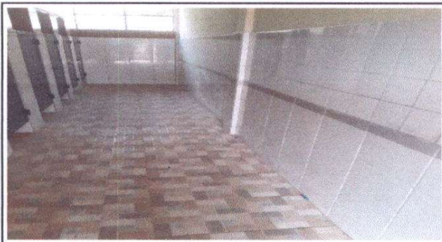
Instalación de azulejo y piso antideslizante.
