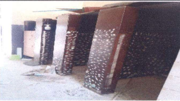
Sustitución de puertas de 0.90 x 1.40 mt.
