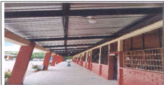
Reparación sistema eléctrico (cambio de lamparas, cableado, interruptores dobles) SALONES DE CLASES, MODULO 1
