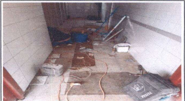
Instalación de azulejo y piso antideslizante.
