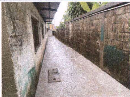
Foto 1: sustitución de losa de patio
