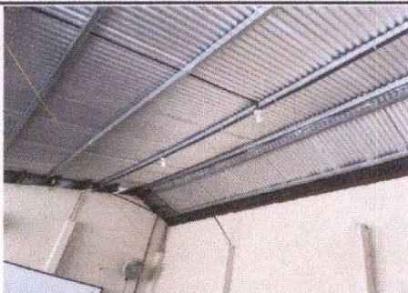
Foto 5: sustitución de cableado eléctrico
