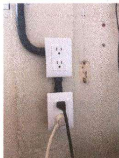
Foto 6: sustitución de switches
