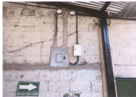
Foto 4: sustitución de tablero monofásico
