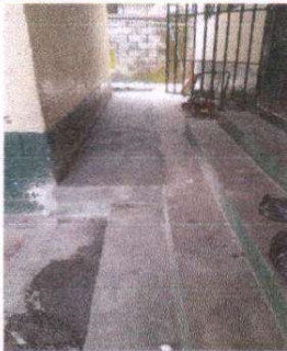
Foto 3: sustitución de losa de patio
