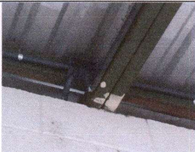
Foto 5: sustitución de cableado eléctrico
