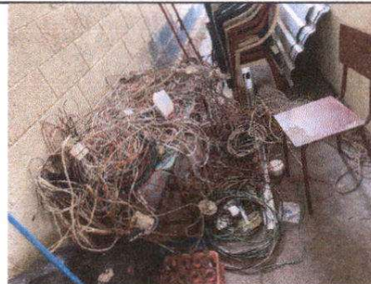
Foto 6: sustitución de switches
