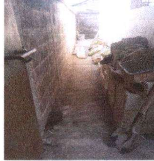
Foto 2: sustitución de losa de patio
