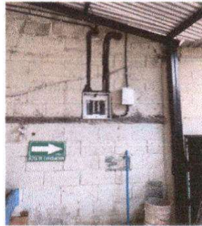
Foto 4: sustitución de tablero monofásico
