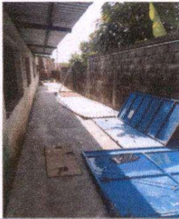
Foto 1: sustitución de losa de patio
