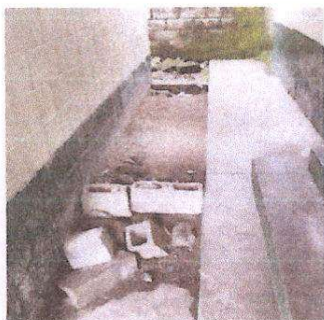
Foto 3: Sustitución de losa de patio
