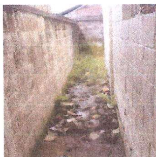
Foto 2: Sustitución de losa de patio
