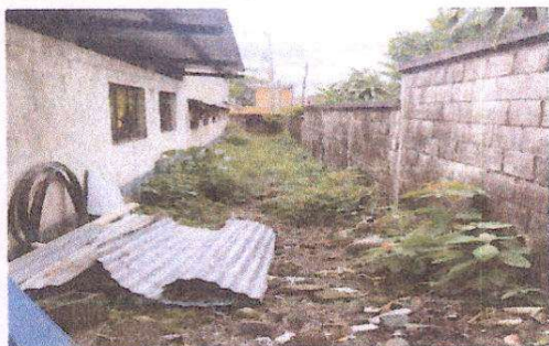
Foto 1: Sustitución de losa de patio
