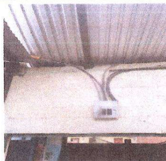
Foto 4: Sustitución de tablero monofásico
