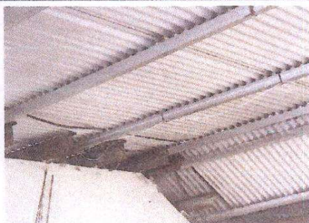
Foto 5: Sustitución de cableado eléctrico
