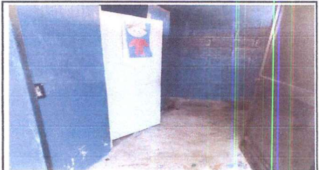
Foto 4: Reparación de servicios sanitarios y sus accesorios
