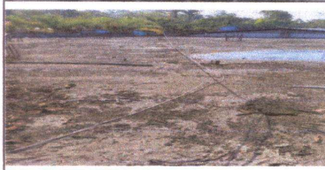
Foto 6: Ampliación del tendido eléctrico hacia la cocina
