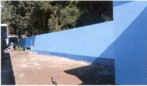
Foto 3: Pintar muro de contención interior del Centro Educativo
