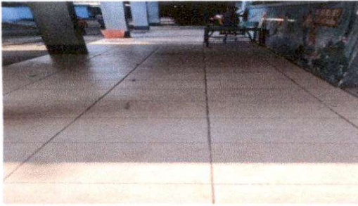
Foto 1: Cambio de piso de concreto a antideslizante módulo 2.
