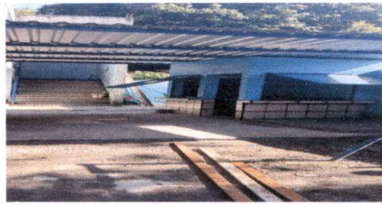
Foto 2: Remodelación de Cocina de Preprimaria
