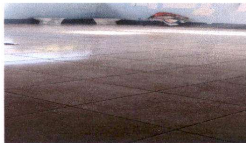
Foto 6: Cambio de piso liso a antideslizante en 1 aula.
