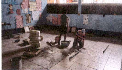
Foto 6: Cambio de piso liso a antedreslizante en 1 aula.
