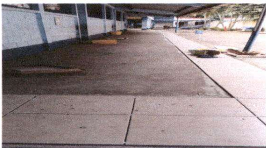
Foto 5: Cambio de Piso de concreto a antedreslizante módulo 1.
