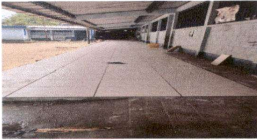
Foto 1: Cambio de piso de concreto a antedreslizante módulo 2.
