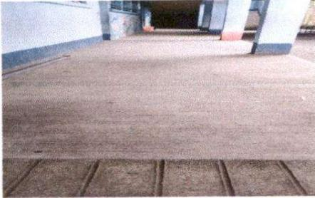
Foto1: Cambio de piso de concreto a antideslizante módulo 2.
