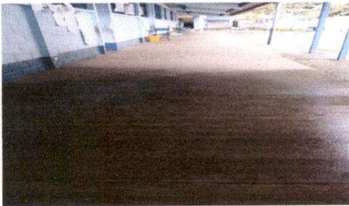
Foto 5: Cambio de Piso de concreto a antideslizante módulo 1.
