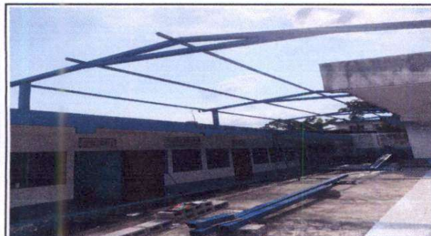
Foto 3: Estructura de techo
