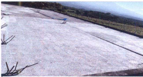
Foto 5: Reparación de pañuelos
