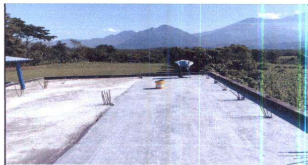
Foto 6: Impremiabilización de loza
