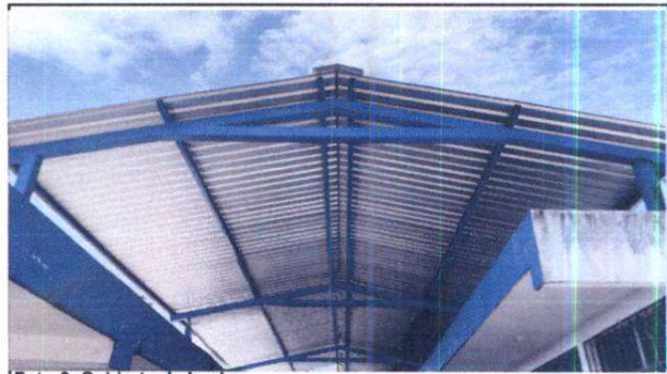
Foto 2: Cubierta de lamina
