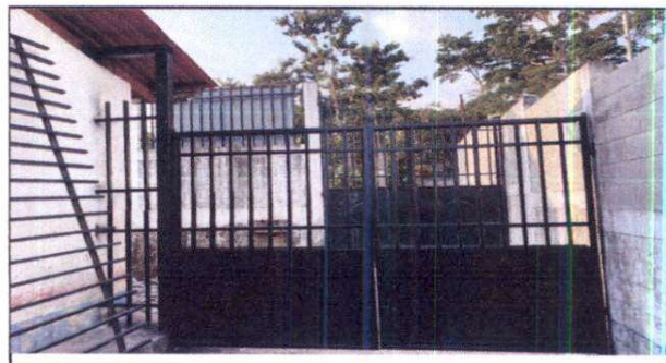
Foto 4: mantenimiento a portones
