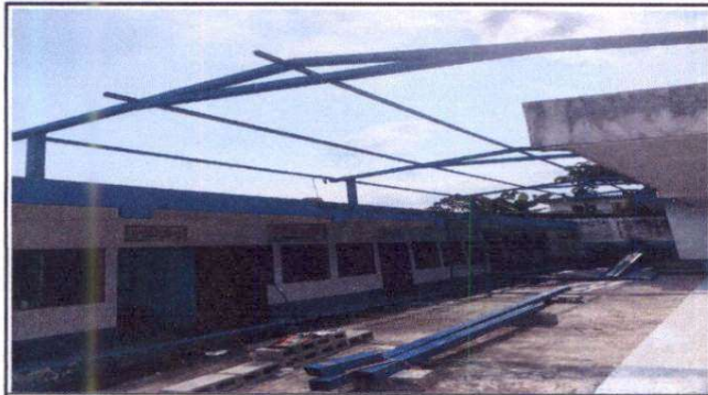
Foto 3: Estructura de techo
