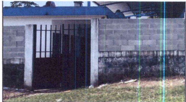
Foto 4: mantenimiento a portones
