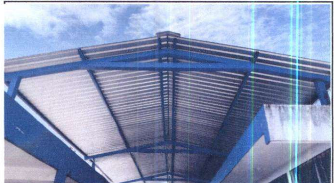
Foto 2: Cubierta de lamina
