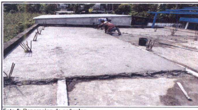
Foto 5: Reparacion de pañuelos
