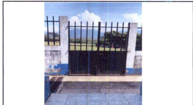
Foto 4: mantenimiento a portones
