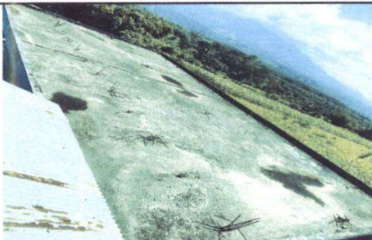
Foto 5: Loza de aulas
