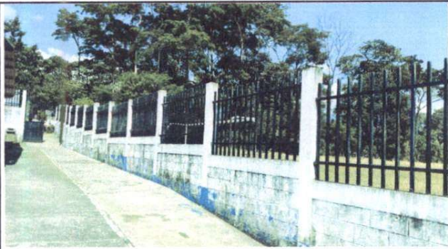
Foto1: Muro perimetral que divide campo e instituto
