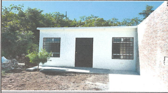
Foto 1: culminación de la reparación del área de cocina
