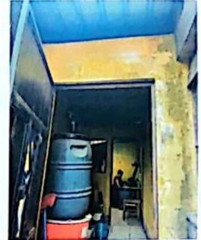
Techado deteriorado y mal ubicado de láminas de la cocina, ha generado que las paredes estén bien deterioradas con mucha humedad.
