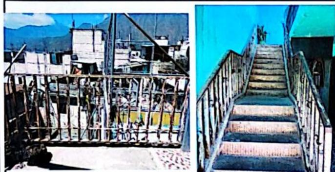
barandas mal colocadas y deterioradas por el tiempo, con material corroído, hecho de material lámina galvanizado
