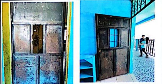
las puertas de las aulas están en estado deplorable, no sirven las chapas; tienen desajuste y material corroído
