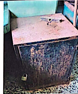
Foto 2: La caja de metal está muy gastada. Necesita ser sustituida.
