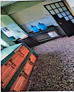
Foto 1: El espacio que ocupa la estufa industrial obstruye el paso de la puerta por lo que necesita demoler repisas para acomodar la estufa.
