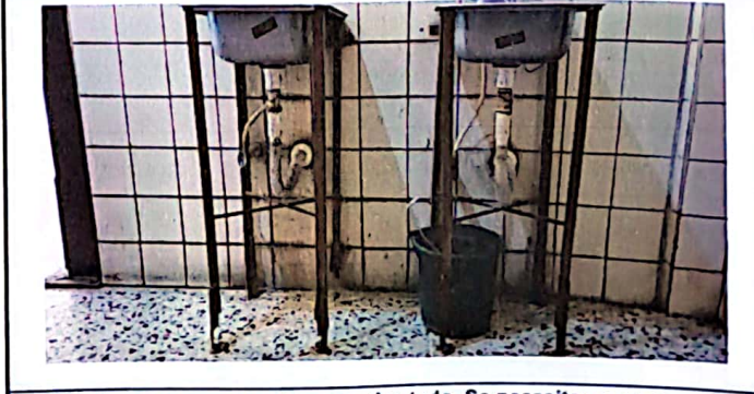
Foto 12: Los lavamanos están en mal estado. Se necesita nuevos lavamanos y fundir repisa de concreto con azulejos.
