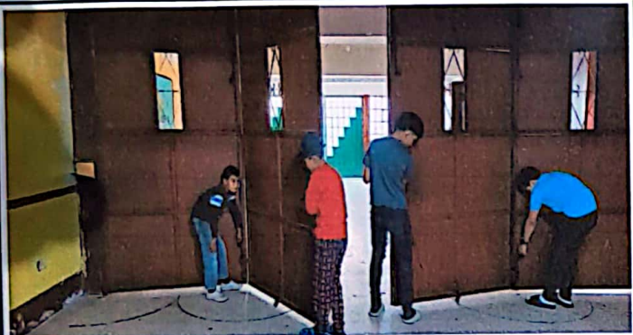
Foto 7: el portón presenta trabas en momento de abrir. Necesita ser reemplazada por una nueva.
