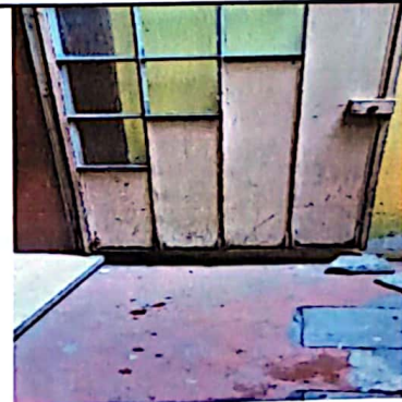
Foto 6: La puerta está oxidada. Necesita ser reemplazada por una nueva. En otras puertas, cambio de chapas.
