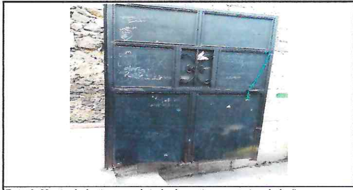
Foto 6. Mantenimiento mas pintada de porton y puertas de baño.
