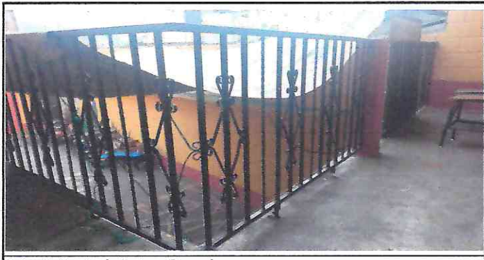
Foto 5: Mantenimiento a Barandas
