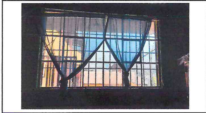
Foto 3: cambio de ventana de direccion y cocina
