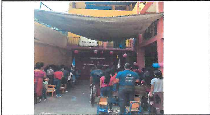
Foto 1: Cubierta de Laminas, estructura de techo con su respectiva reparacion del sistema electrico.
