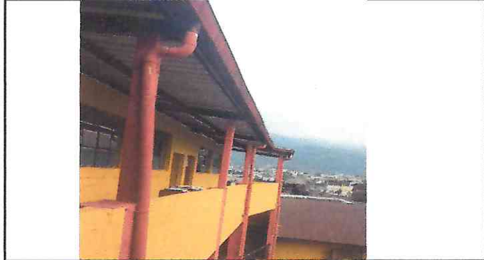
Foto 4: Canales y bajadas de aguas pluviales
