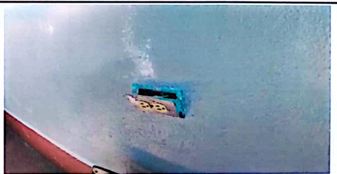
Foto 6. Los cables, tomacorriente y apagadores en mal estado . Es un problema para la comunidad educativa, los niños pueden meter sus manos donde esta roto.
