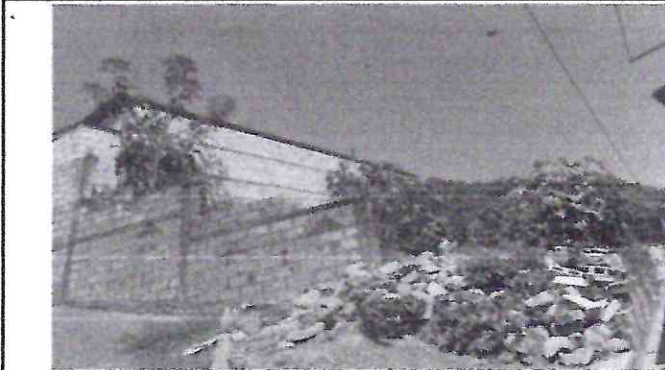
FOTO 3 Vista de la reparación del lado derecho
